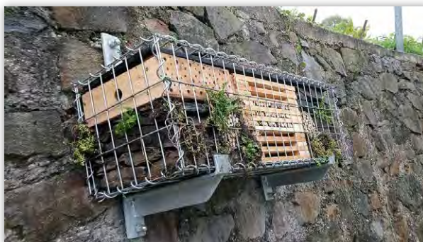
Hängegabione an Stützmauer
